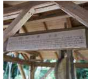
現存する「新水の井」
