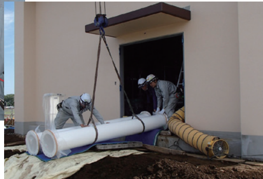
▼配管の搬入作業
