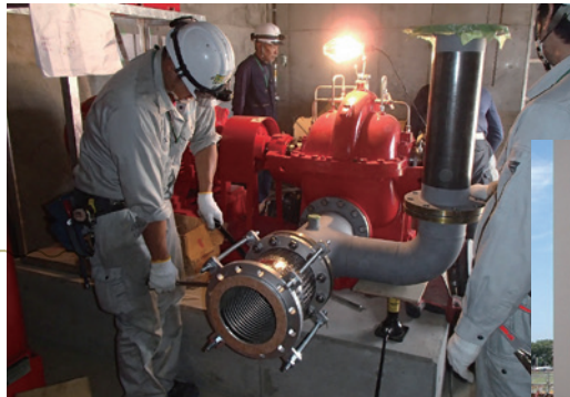
◀ポンプ周りの配管工事
